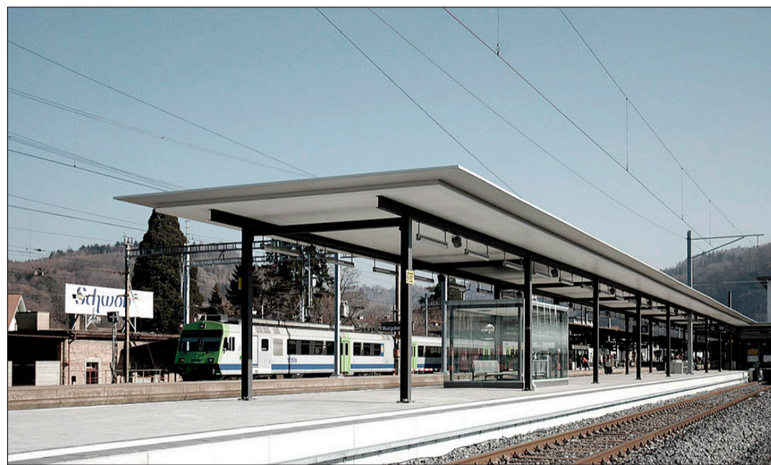
Das von der SBB genormte Perrondach ist zwar schweizweit dasselbe – und doch passt es sich den lokalen Gegebenheiten auf subtile Weise an.
