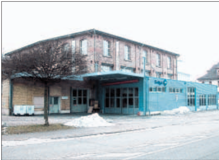
Der vorgelagerte blaue Bau passt nicht ins Stadtzentrum; er scheint einem Industriequartier am Stadtrand davongelaufen zu sein.
